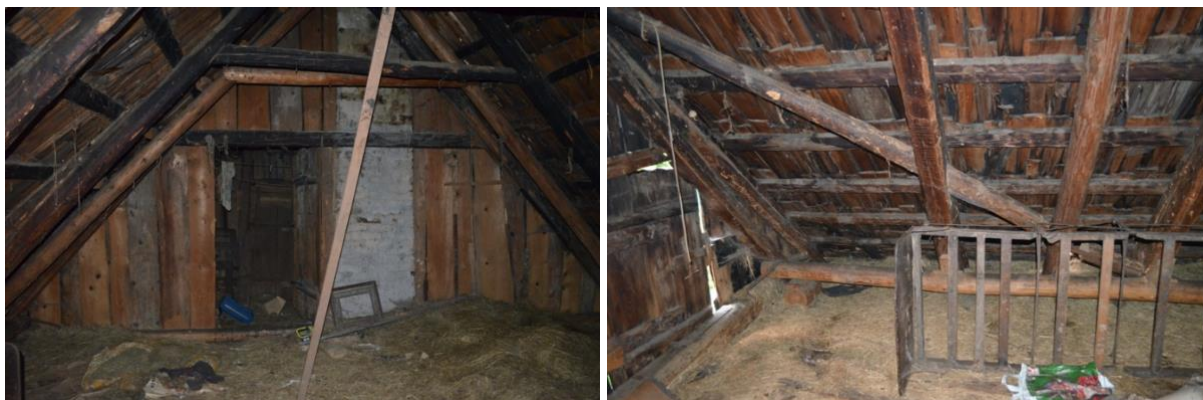
Obr. 13 Pohledy do prostoru krovové konstrukce nad světnicí.
