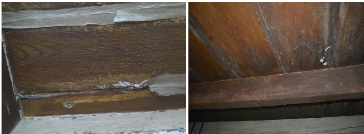
Obr. 23 Detail záklopových prknech stropu ve světnici, bez známek poškození.
