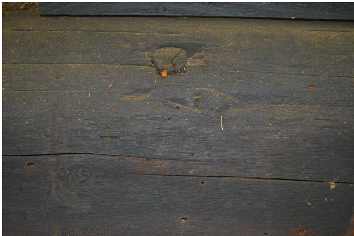
Obr. 27 Detail zbytku houžvi po plavení dřeva, JZ stěna roubení z exteriéru.
