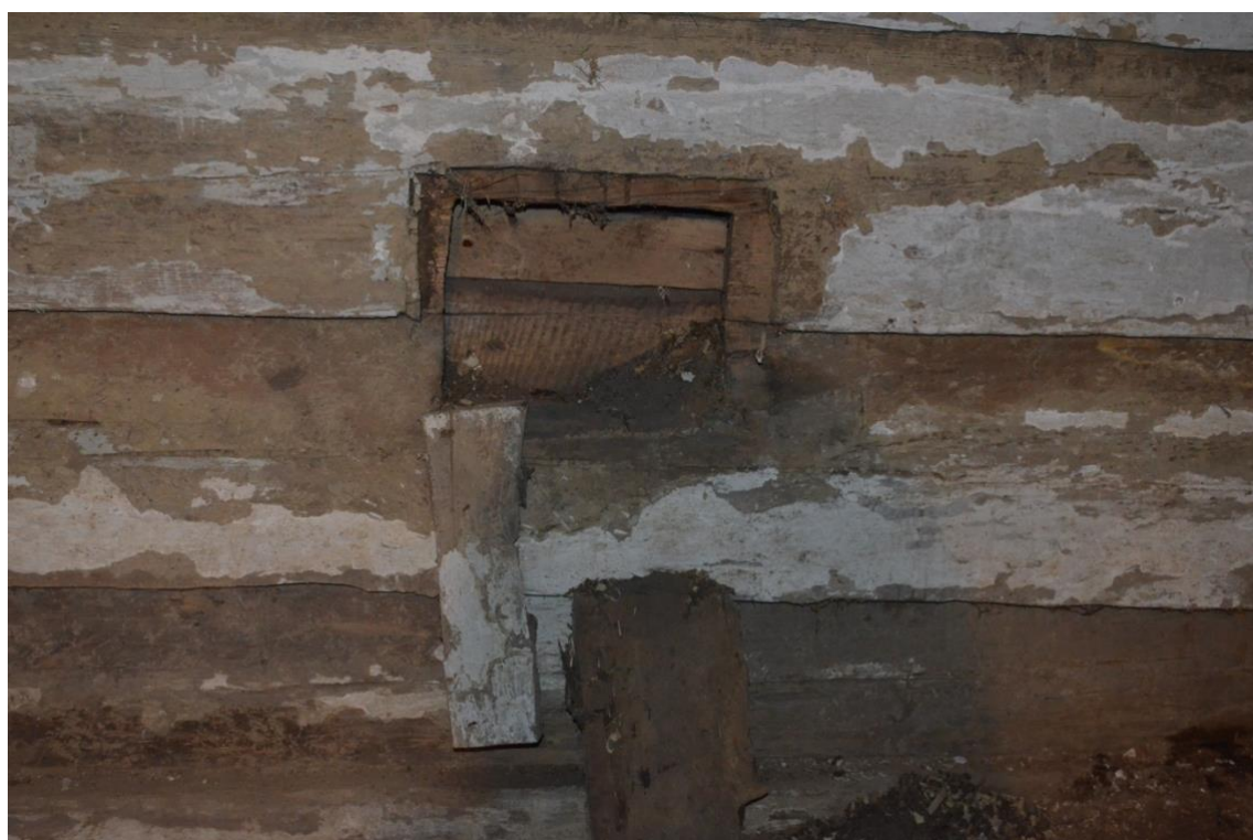
Obr. 28 Ukázka detailu mezi prvky roubení ve stěně komory, účel nebyl specifikován.
