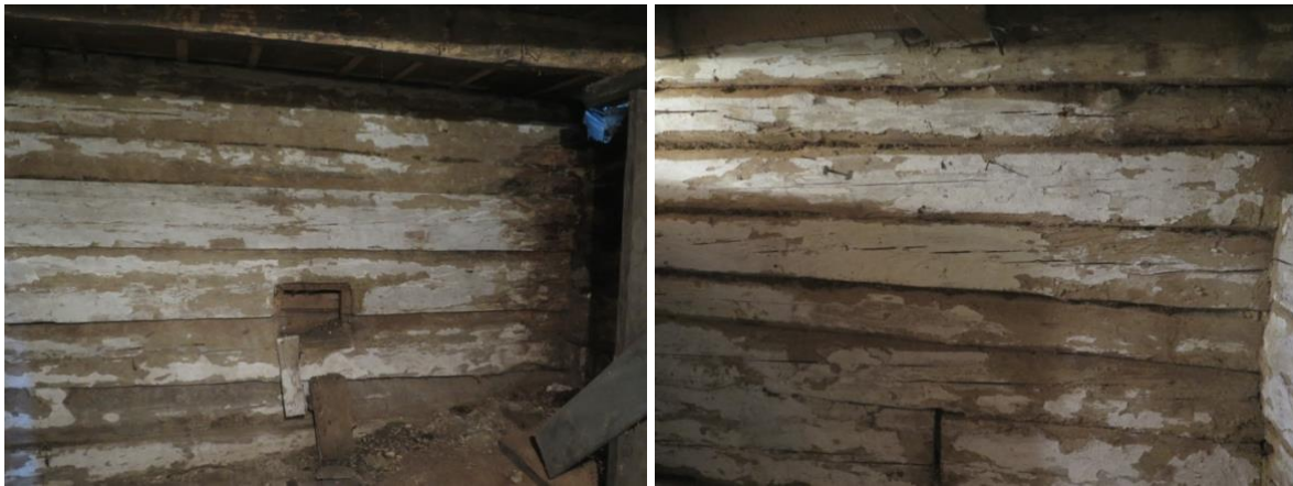
Obr. 6 Ukázka stavu vnitřních příček roubení v komoře, vpravo příčka mezi komorou a chlévem.
