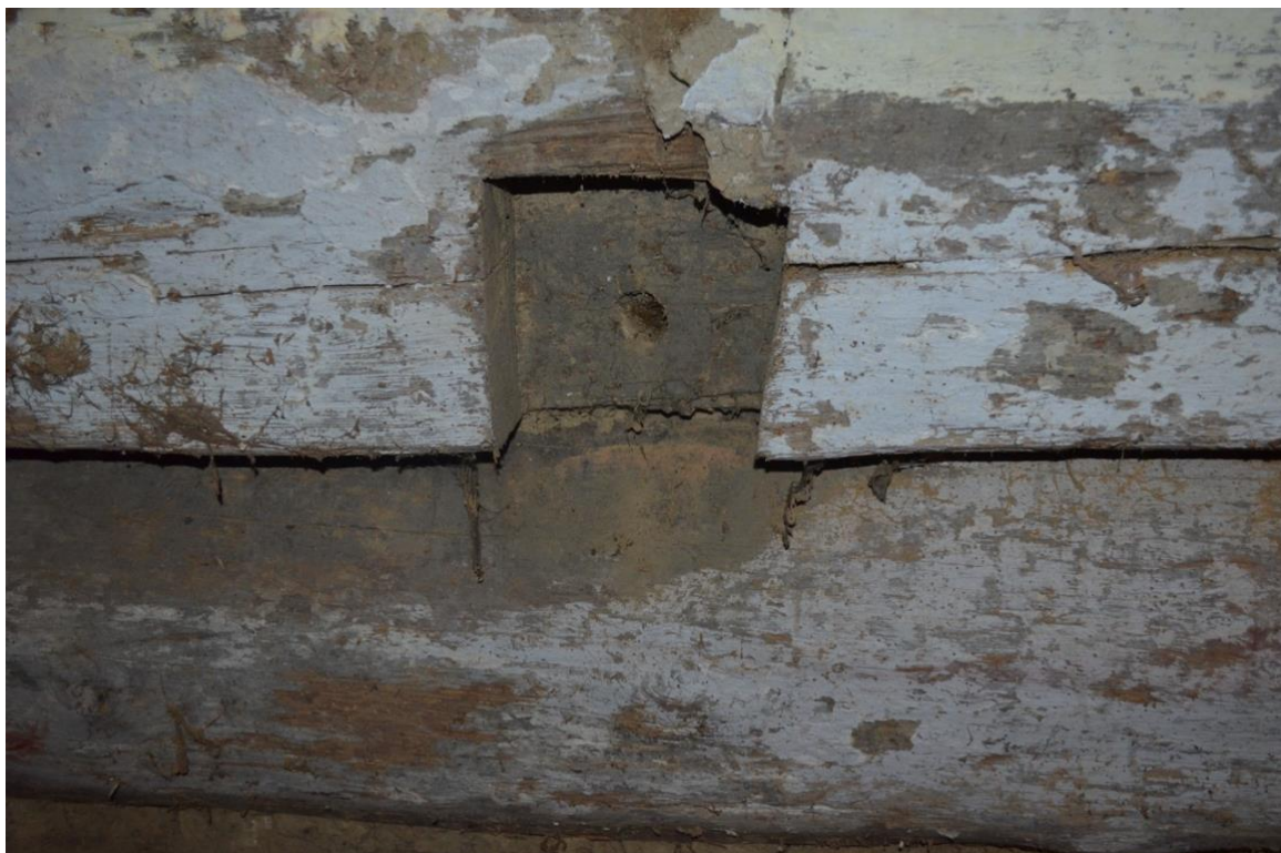
Obr. 29 Dlab v roubení v příčce mezi komorou a síní.
