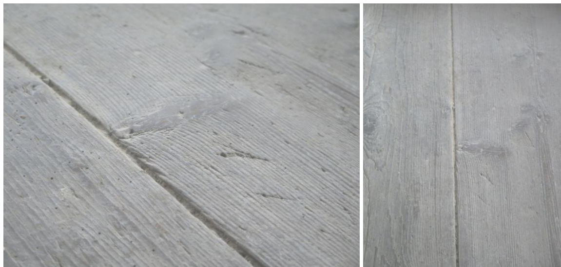
Obr. 31 Detail struktury dřevěné prkenné podlahy ve světnici.
