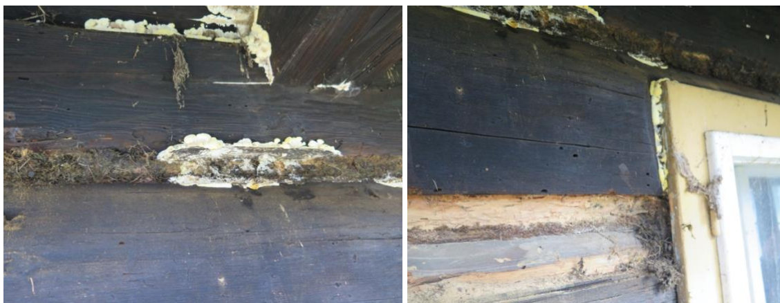
Obr. 11 Detail plodnice dřevokazné houby poprašky sklepni ( Coniophora puteana ) nalezené na JZ stěně ze strany interiéru.
