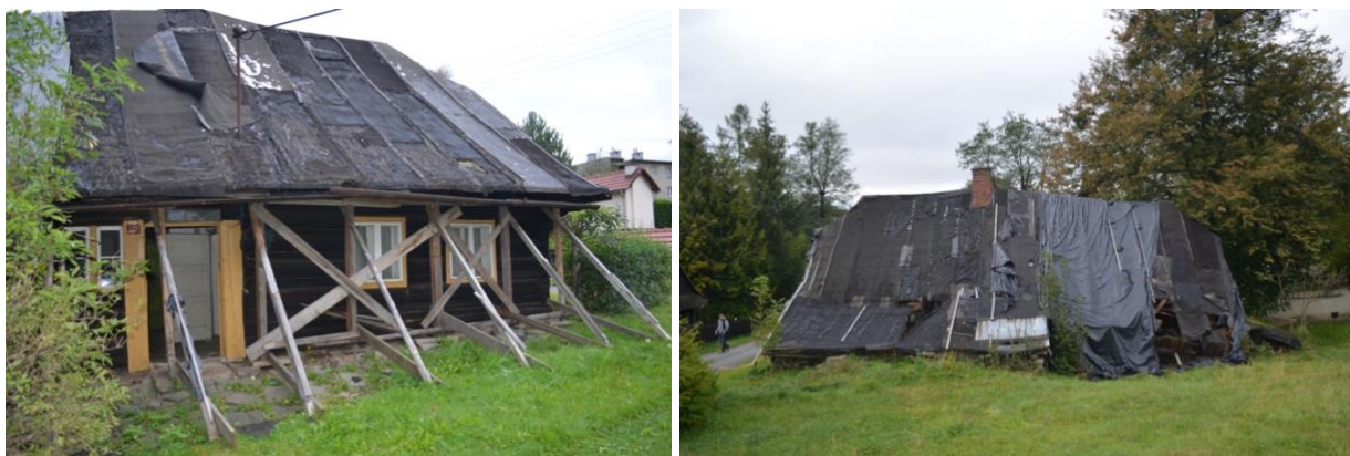
Obr. 3 Vpravo jihozápadní pohled a vlevo severovýchodní pohled na objekt.
