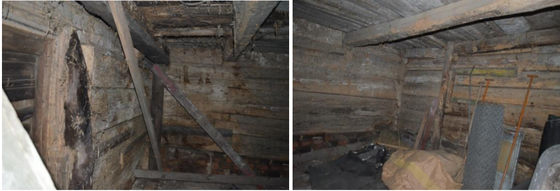
Obr. 8 Pohled na vnitřní roubené příčky ve chlévě.
