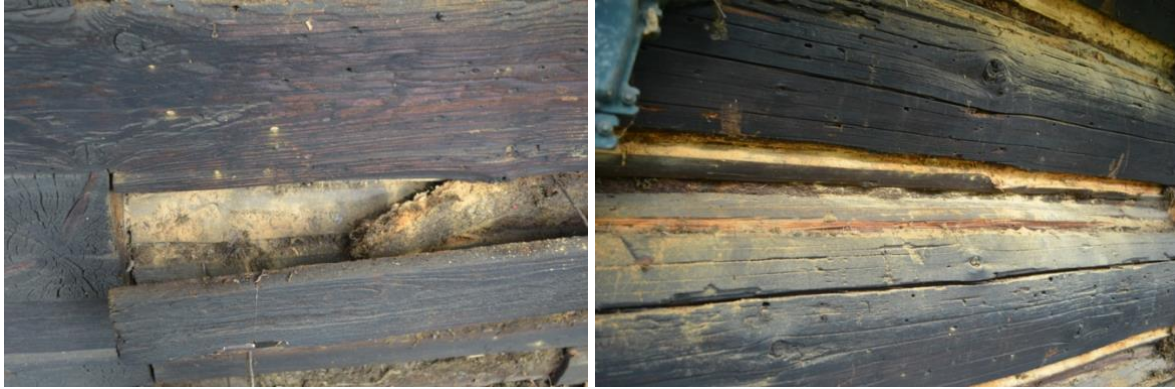
Obr. 5 Detail roubení při demontáži dřevěné lišty a vyjmutí mechu, vpravo detail po demontáži dřevěné lišty, JZ strana.
