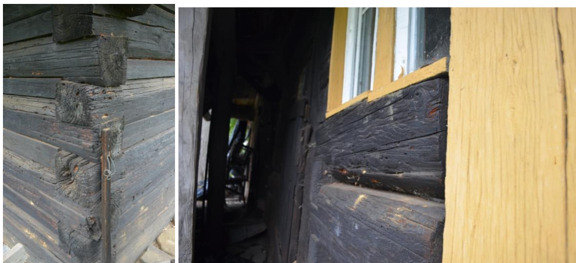
Obr. 4 Detail rohové vazby a roubení na JZ straně.
