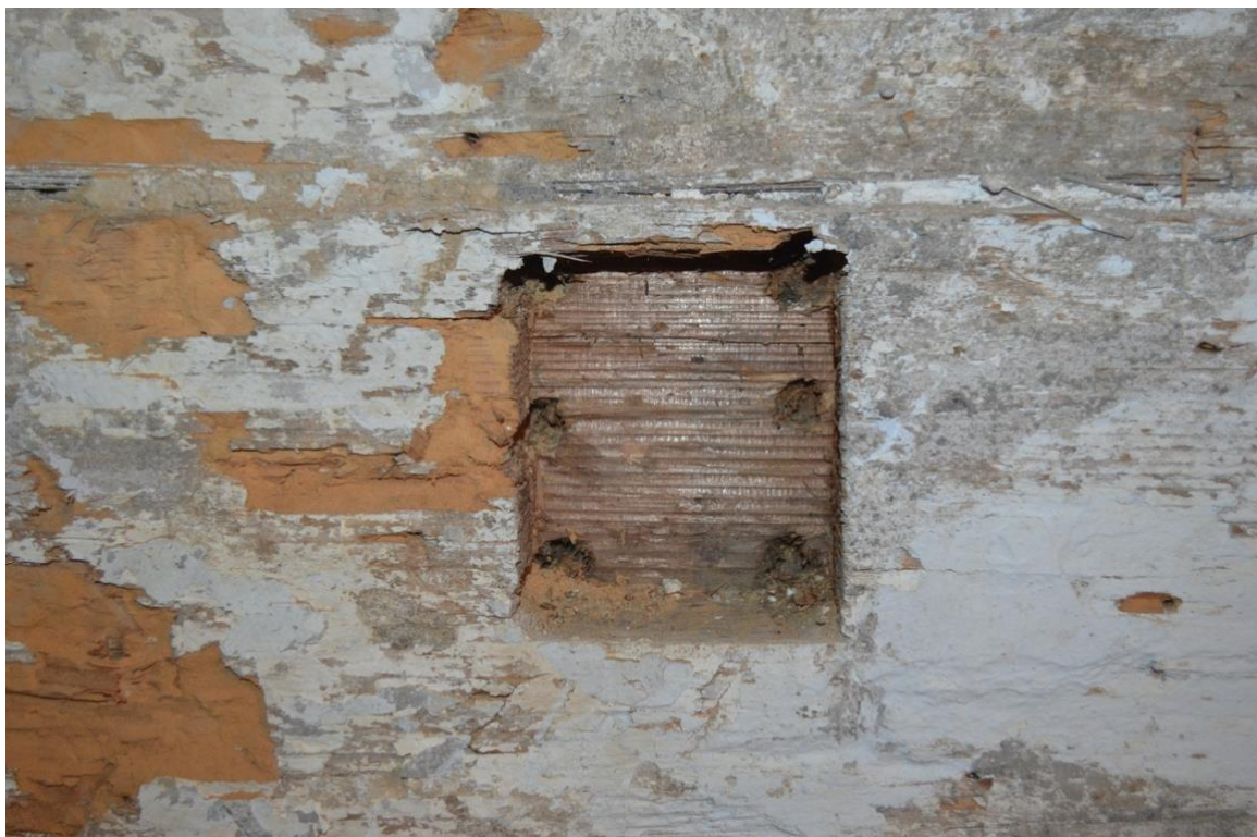
Obr. 25 Jeden ze tří dlabů v prvku roubení na JZ stěně ze strany interiéru.
