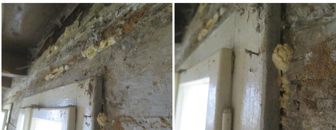
Obr. 11 Detail plodnice dřevokazné houby poprašky sklepni ( Coniophora puteana ) nalezené na JZ stěně ze strany interiéru.
