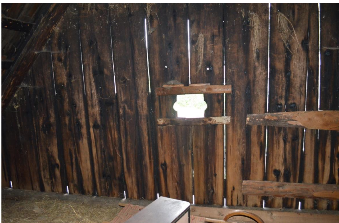
Obr. 24 Detail výzorníku na JV štítu objektu.
