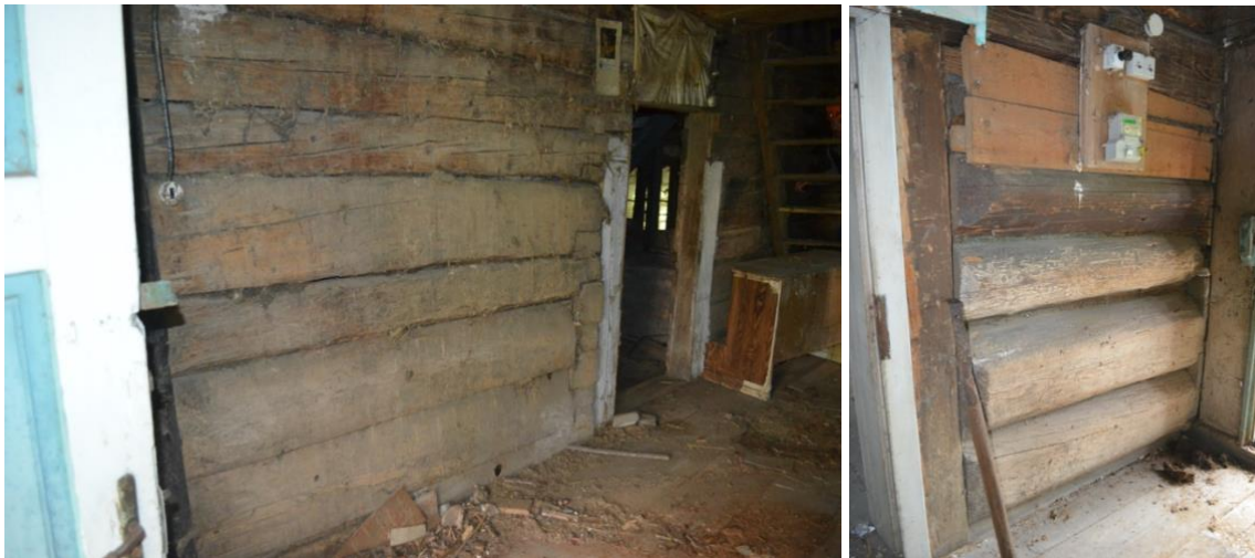
Obr. 9 Pohled na vnitřní roubené příčky v síni. Stěna vpravo je složena z prvků jedlového a z topolového dřeva.
