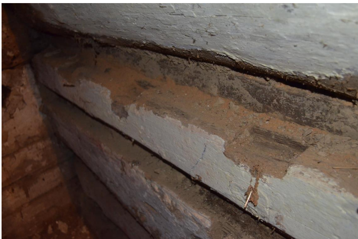
Obr. 30 Dlab v roubení mezi komorou a síní, dle rozestupů je možné se domnívat, že jde o ližinu ze sušárny ovoce.
