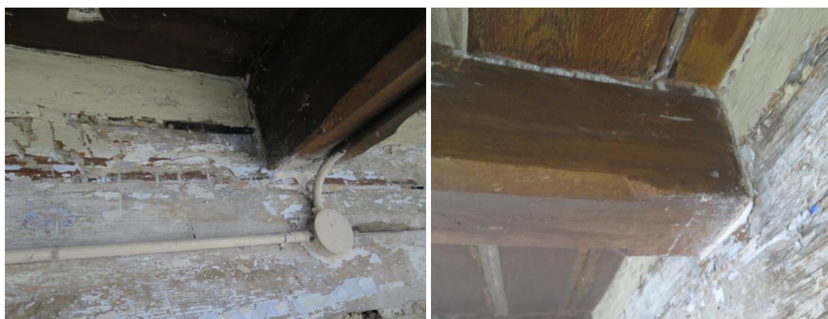
Obr. 22 Detail třetího stropního trámu ze strany interiéru bez poškození.
